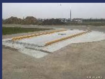
Silniční mostové váhy
