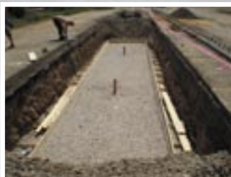
Příprava - zhuštěné lože na odvod vody.
