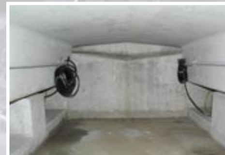
Prefabrikovaný robustní odvažovací most - pohled do útrob váhy.
