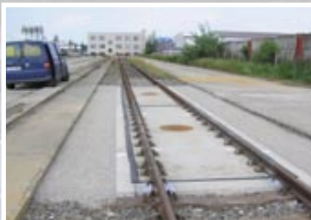
Precizní kolejová váha - kolejová váha s prefabrikovaným základem.
