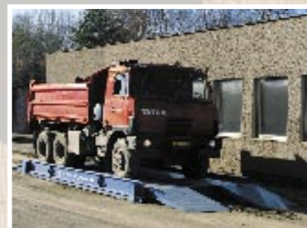
vážení s vybagrovanou zemínou
