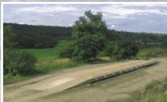
GRAVEX concrete LS 18m/60t - pískovna Libčice nad Vltavou
