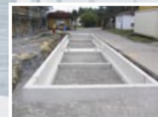
Prefabrikovaný základ pro váhy GRAVEX concrete - zapuštěné provedení (typ 14-95)
